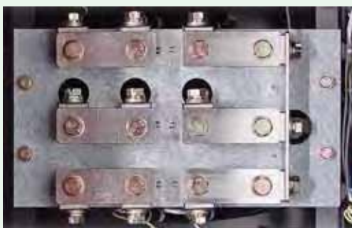
▲ 電圧切替端子板
